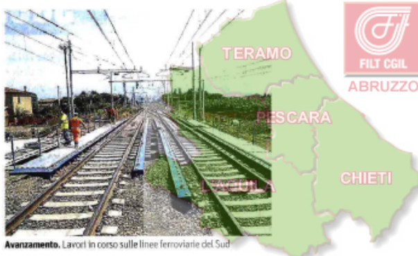
Avanzamento. Lavori in corso sulle linee ferroviarie del Sud
