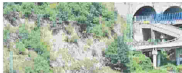
▲ Il cantiere | I lavori a Chiomonte
