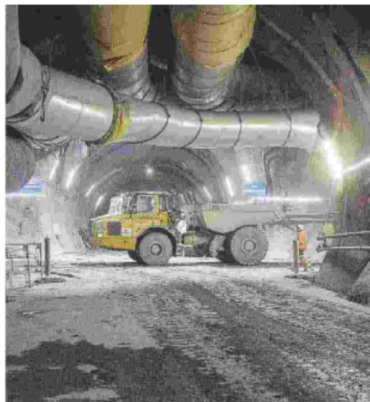
Il tunnel Il cantiere del Tav a Saint Martin La Porte, in Francia. Ansa
